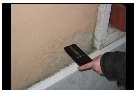
La misurazione dell'umidità del muro
